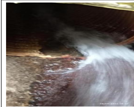
FOTO 03. Deterioro prematuro o daños en la red de Alcantarillado Diam. 42" que fue instalada con recursos contrato Levantó. Ángela María Duque Agudelo y Juan David González Orozco – Profesionales Universitarios
